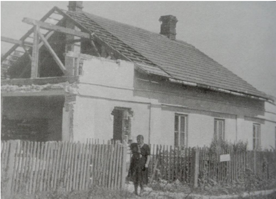
74. Dom Płaszków w trakcie ozbiorki
