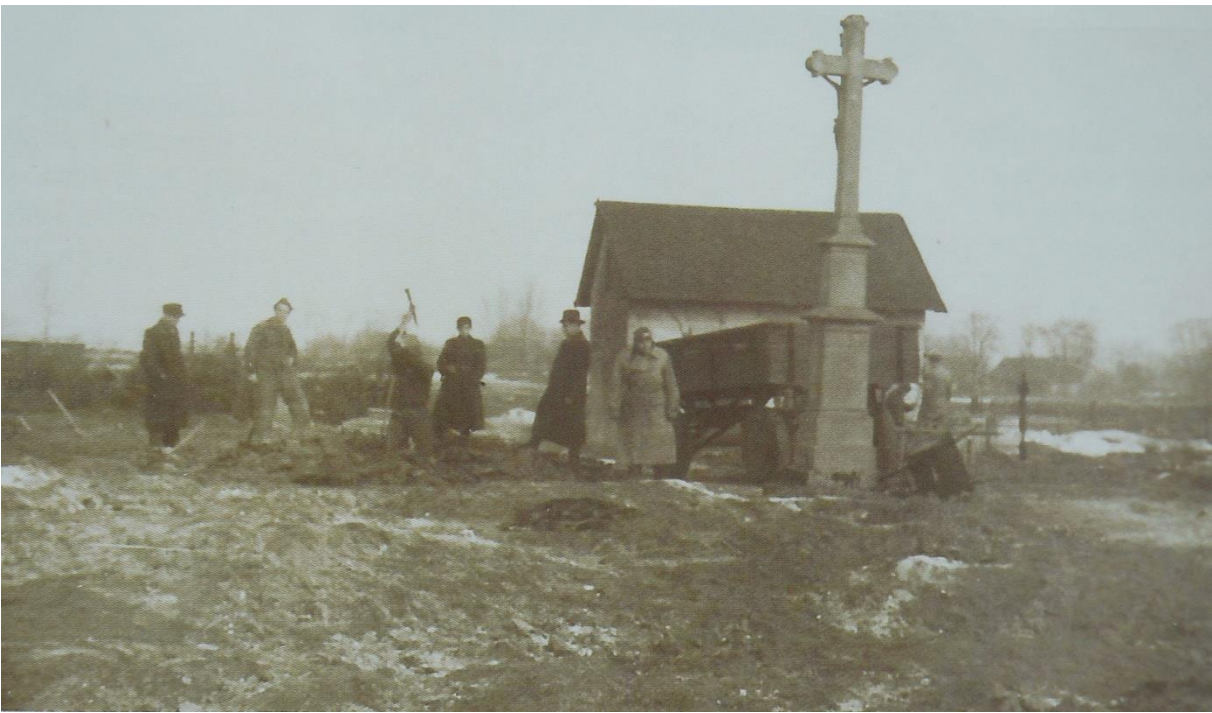
78. Ostatnie groby w trakcie ekshumacji, widoczny krzyż cmentarny
