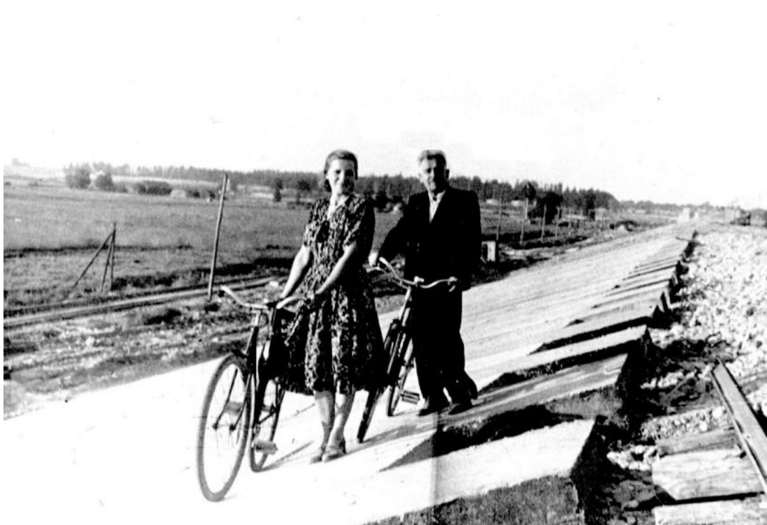
79. Korona zapory w trakcie budowy
