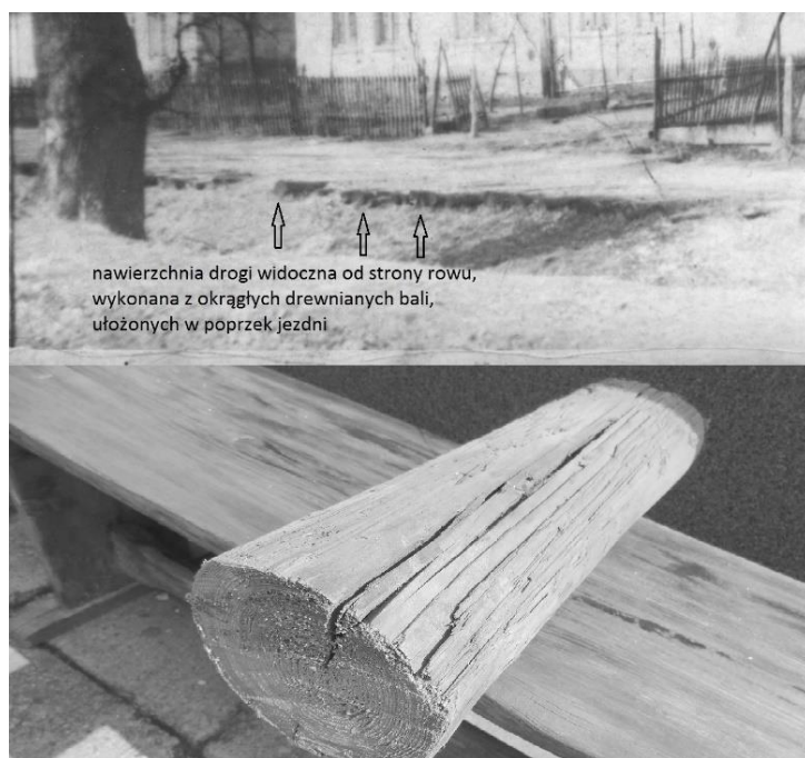
14. U góry widoczne warstwy drogi wykonanej z drewnianych bali w Zarzeczcu i Podjaziu, poniżej oryginalny fragment delówki
